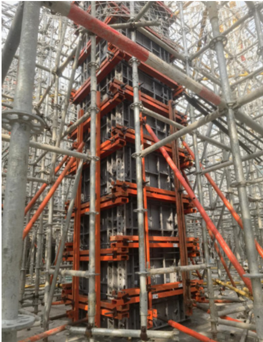
Column Formwork Solution 1 柱模解决方案一
